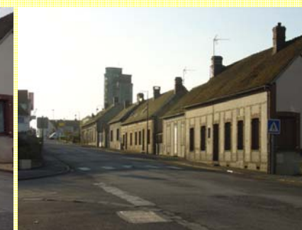
Après les travaux
